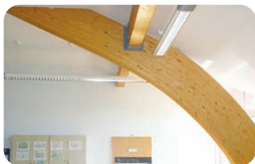
Izdelava ostrešja iz lepljenih nosilcev
